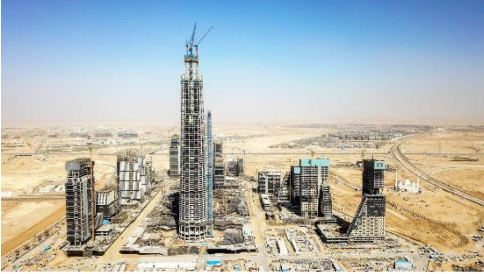
(موقع البناء لمنطقة الأعمال المركزية في العاصمة الإدارية الجديدة لمصر)
